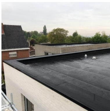
Figuur 12: Aluminium dakrand
