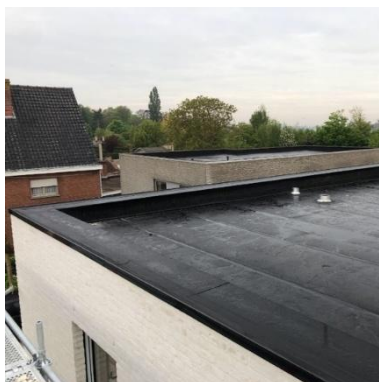
Figuur 14: Aluminium dakrand
