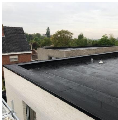
Figuur 16: Aluminium dakrand
